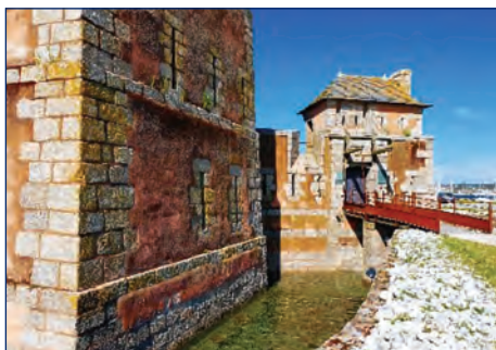
La tour Vauban (©Mairie de Camaret-sur-Mer/ C. Boëzennec)
